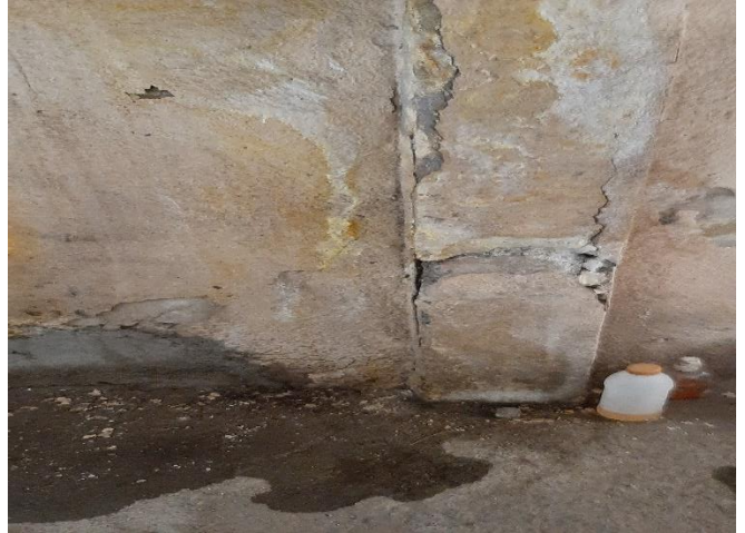
نمایی از بروز رطوبت و ریزش آندوسیمان نمای غربی :
