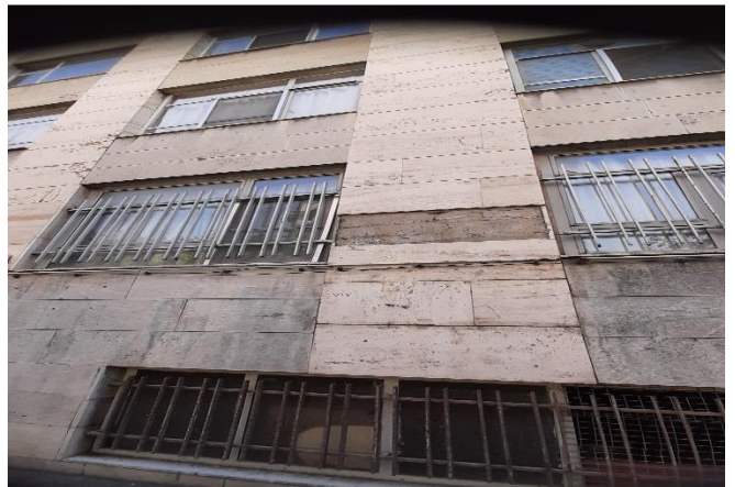
نمایی از بروز رطوبت و ریزش سنگ نمای شرقی:
