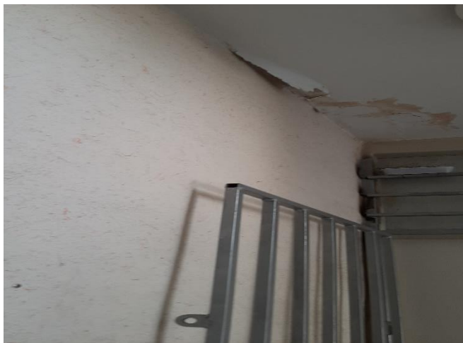
نمایی از رطوبت و ریزش آندوسقف راه پله :
