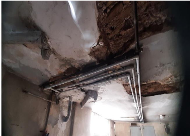
نمایی از رطوبت و ریزش آندوسقف راه پله :
