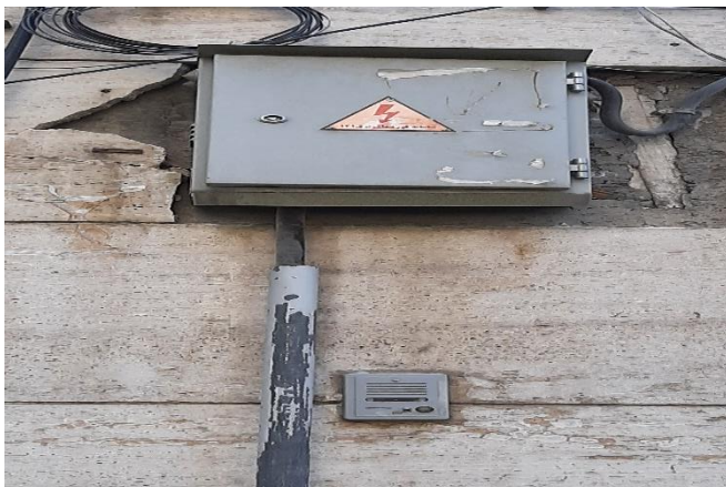
نمایی از بروز رطوبت و ریزش سنگ نمای شرقی:
