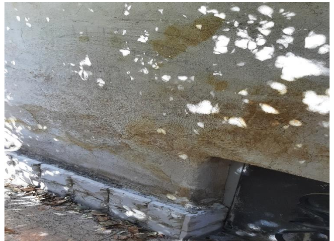
نمایی از بروز رطوبت و ریزش آندوسیمان نمای غربی :
